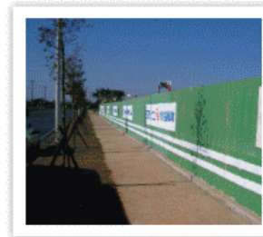
工區周界圍籬 工區周界範圍需完全設置
